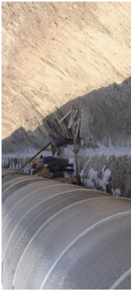
南水北调PCCP管阴极保护项目
